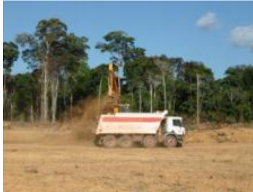
Figura 06: Carregamento do Topsoil . Fonte: AMARAL, 2015.
