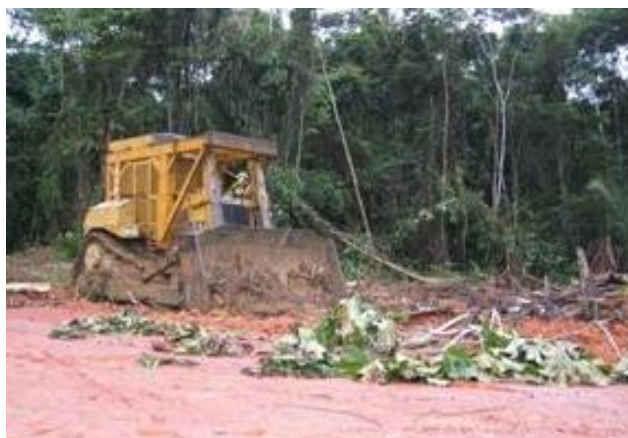
Figura 05: Supressão Vegetal com Trator D6 Fonte: SOUZA, 2014.
