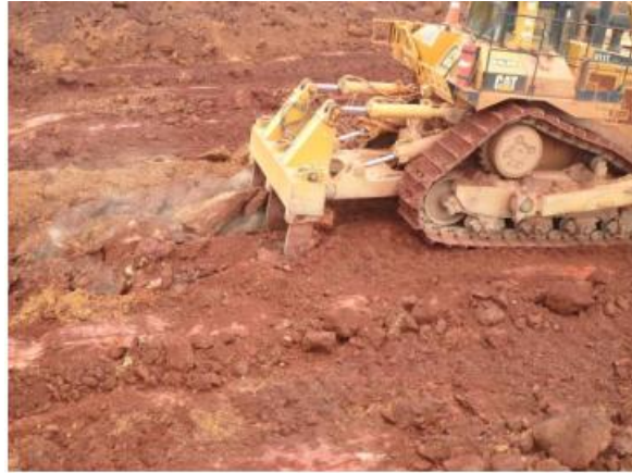
Figura 09: Escarificação com TE D11 Fonte: AMARAL, 2015.
