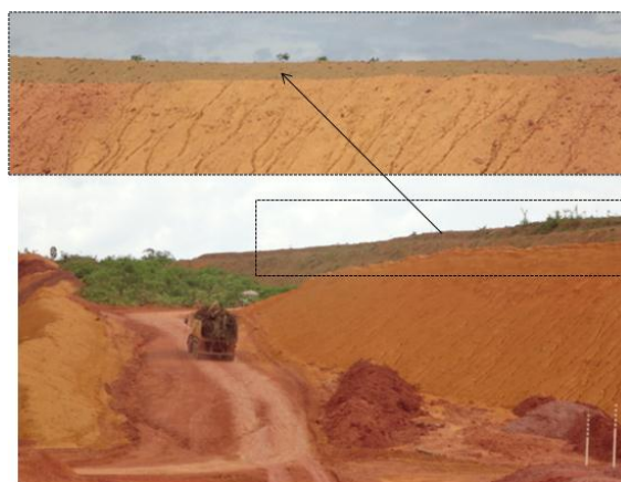
Figura 07: Recomposição com Topsoil . Fonte: SOUZA, 2014.
