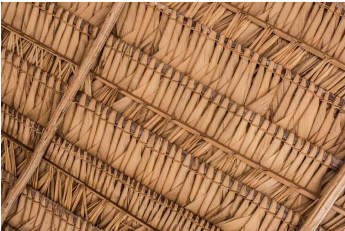
FIGURA 40 – Detalhe de telhado construído com o uso intercalado de palhas de ubim e inajá, apoiadas em enviras às quais são amaradas com cipó do tipo ambé. Foto: Ítala Nepomuceno, jul. 2015.
