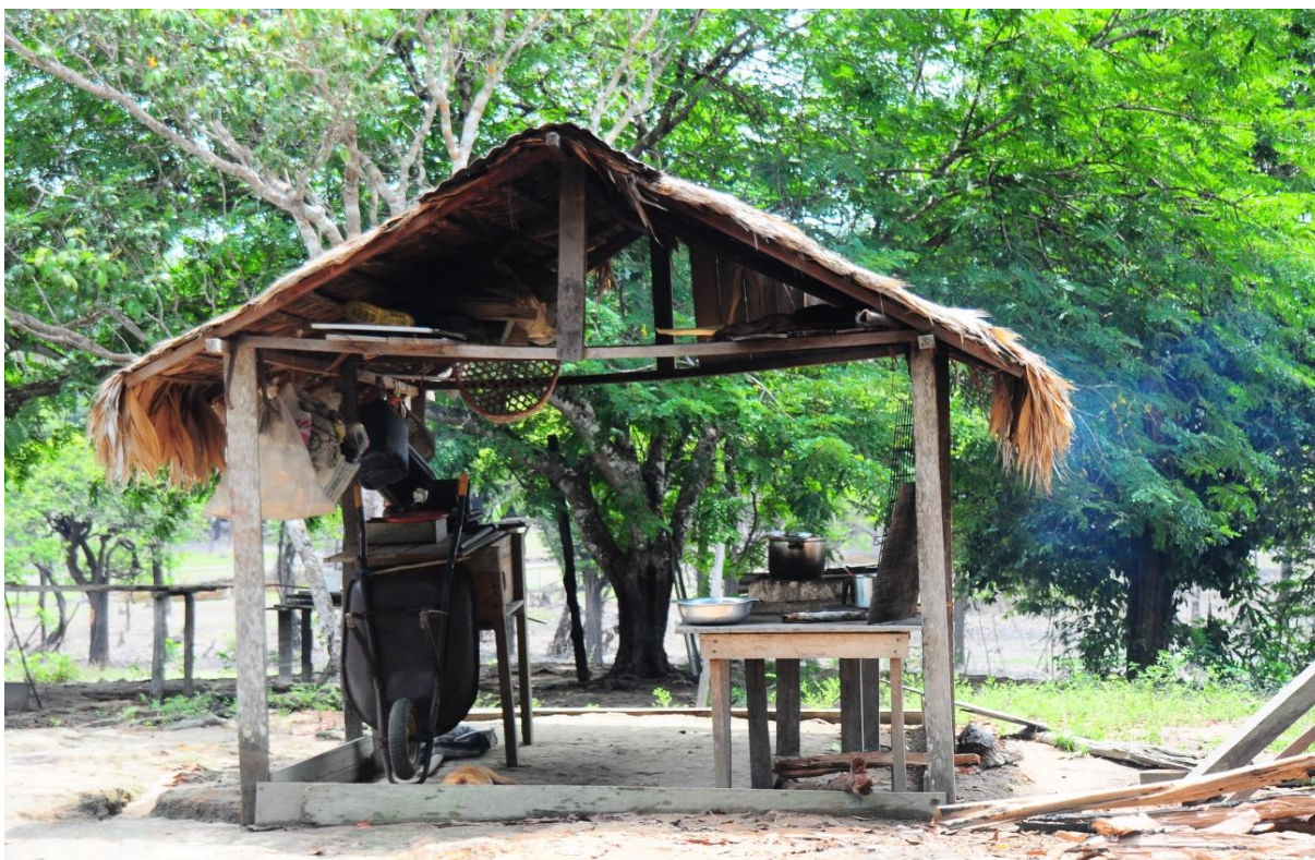
FIGURA 39 – Telhado de palha cobre uma cozinha externa à moradia, arranjo arquitetônico bastante comum na região. A maioria das famílias da comunidade substituiu a cobertura de palha das casas por telhas industrializadas, mas continua com seu emprego nos ambientes externos. Foto: Ítala Nepomuceno, jul. 2015.
