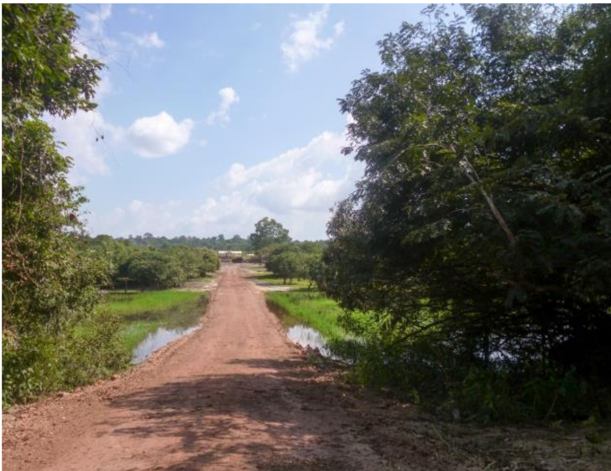
FIGURA 68 – Vista do chão do segmento de estrada (aterro) que liga o porto das madeireiras ao furo do Ajará durante a seca.
