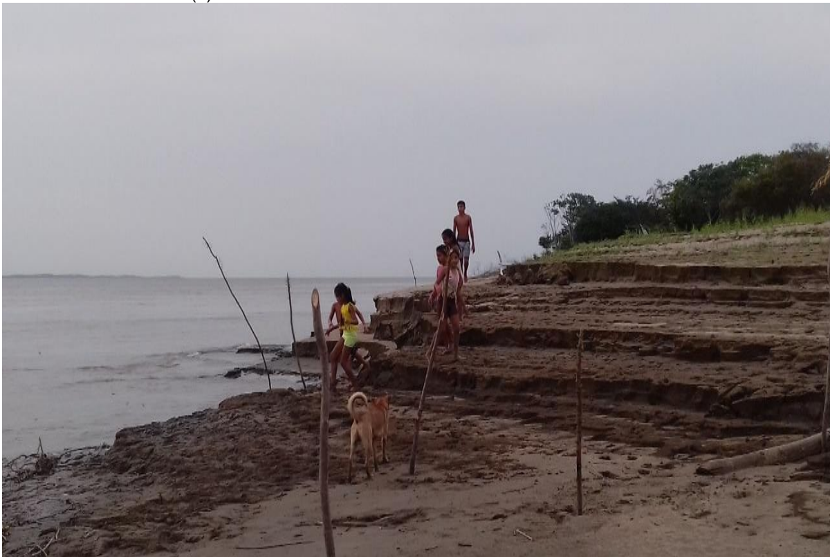
Fotografia 3 - Terraços de várzeas e acesso das pessoas ao rio Amazonas na Comunidade São Ciríaco do Urucurituba (1)
