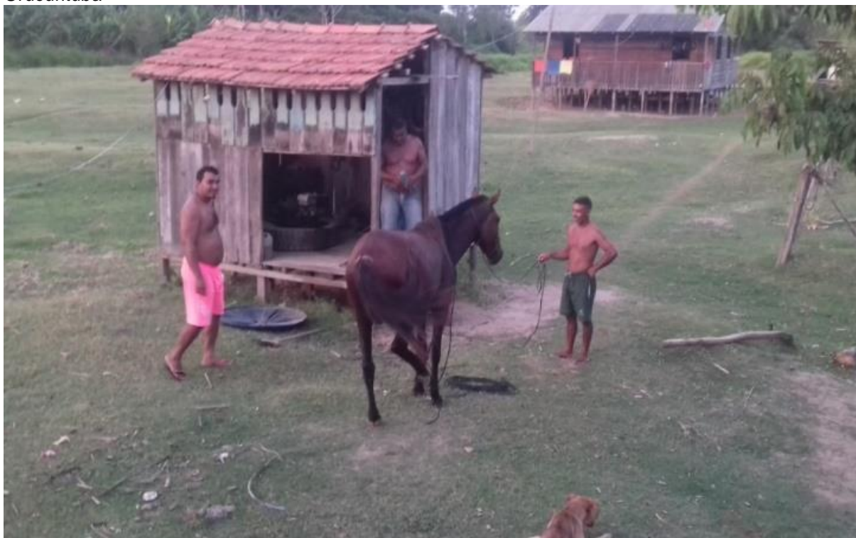
Fotografia 26 - Compartimento do motor à diesel “casa de força” na Comunidade São Ciríaco do Urucurituba
