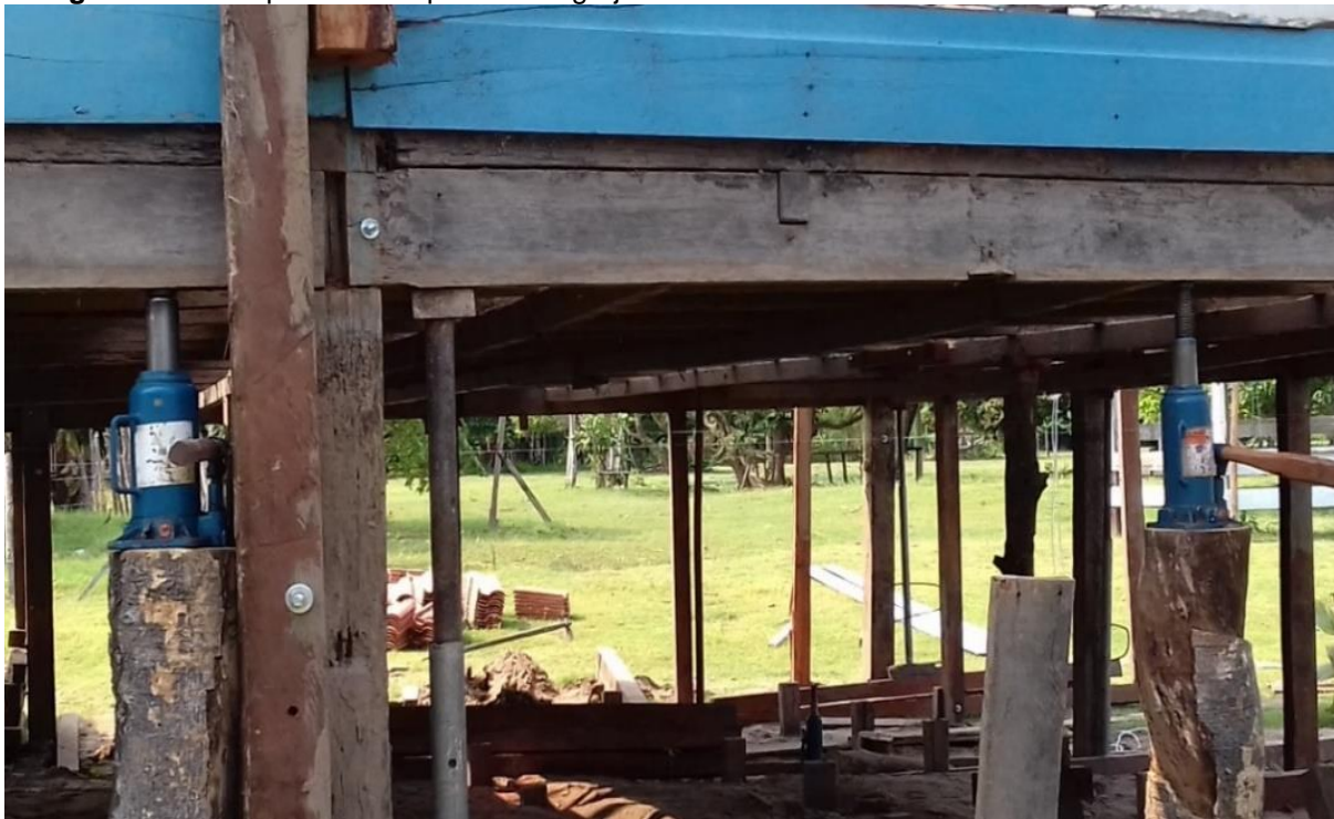
Fotografia 29 - Suspensão dos pilares da Igreja católica na Comunidade São Ciríaco do Urucurituba
