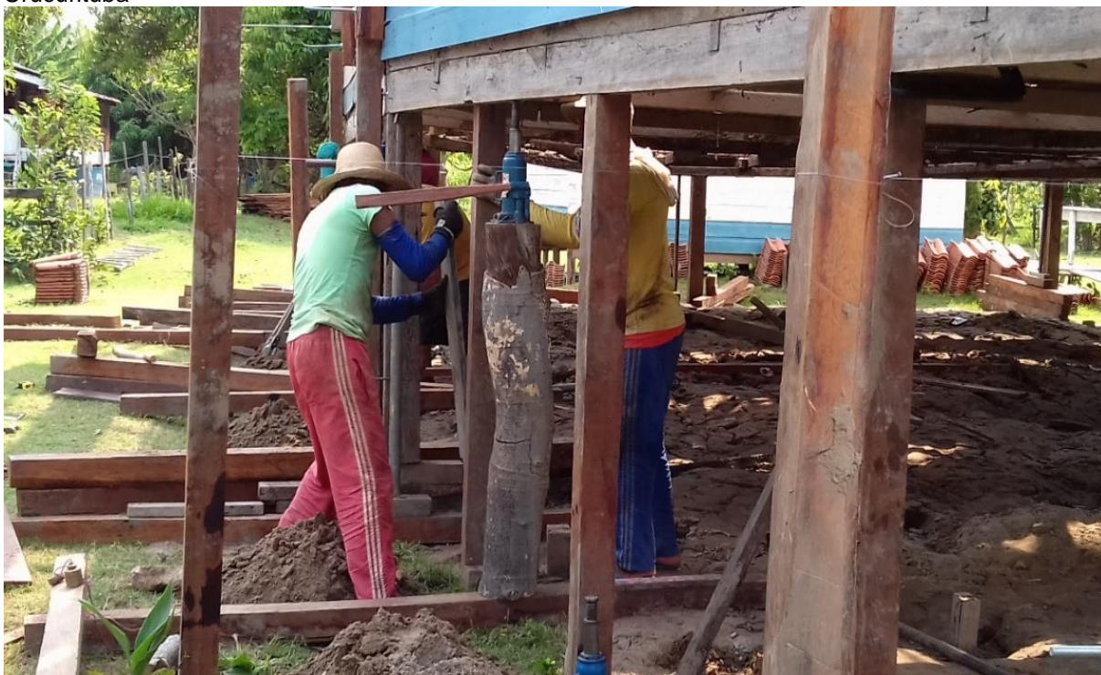
Fotografia 30 - Moradores suspendendo os pilares da Igreja católica na Comunidade São Ciríaco do Urucurituba
