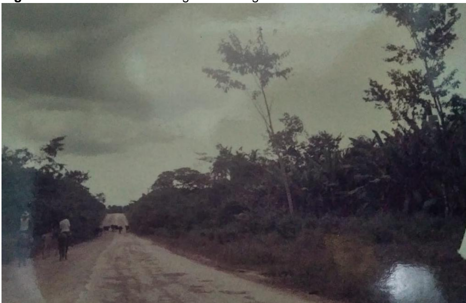
Figura 25 - Comunitários trafegando com gado na rodovia deteriorada
