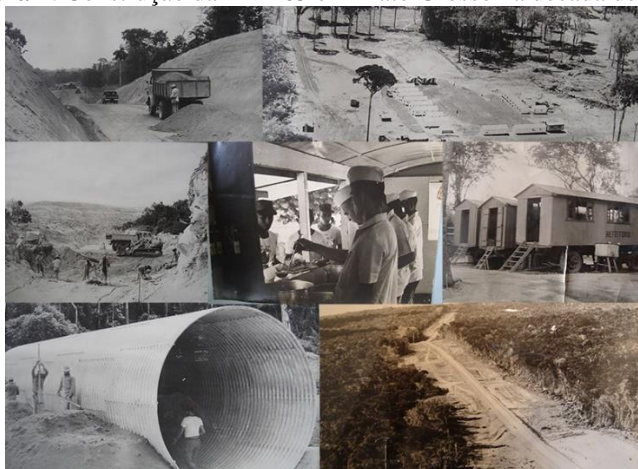
Figura 2. Construção da BR-163 em Mato Grosso na década de 1970
