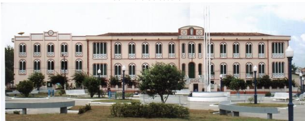
Figura 6 – Fotografia da Escola Confessional Santa Terezinha – Bragança/PA- Construção do início do século XX
