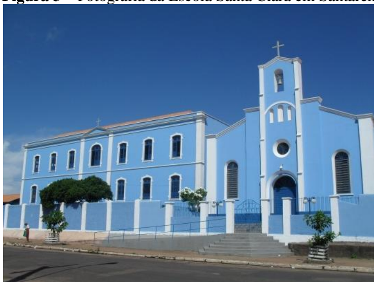
Figura 3 – Fotografia da Escola Santa Clara em Santarém
