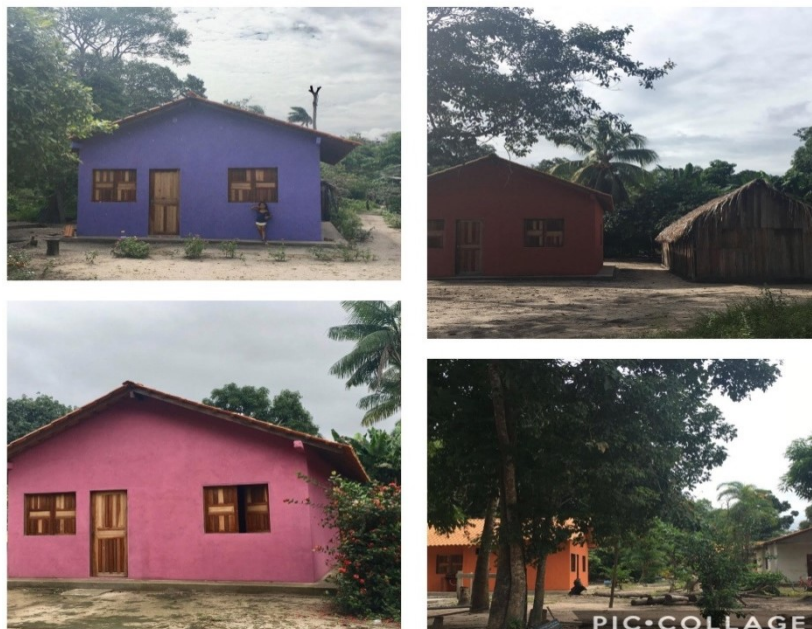
Figura 7 - Exemplos de casas construídas por meio do PNHR, em projeto liderado pela AMPROSURT, na Comunidade Surucuá- Reserva Extrativista Tapajós-Arapiuns, Pará, Brasil.
