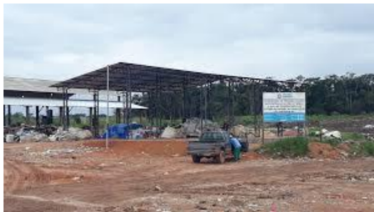
Figura 9 – Galpão instalado no aterro do Perema, onde os catadores indireto realizam suas atividades.
