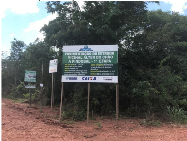
Fotografia 14 - Placa indicando pavimentação asfáltica estrada Alter do Chão Pindobal
