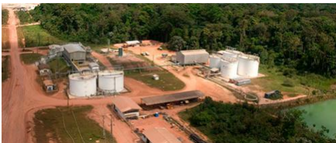
Figura 03 – Planta da empresa Imerys Caulim S/A no Rio Capim -PA
