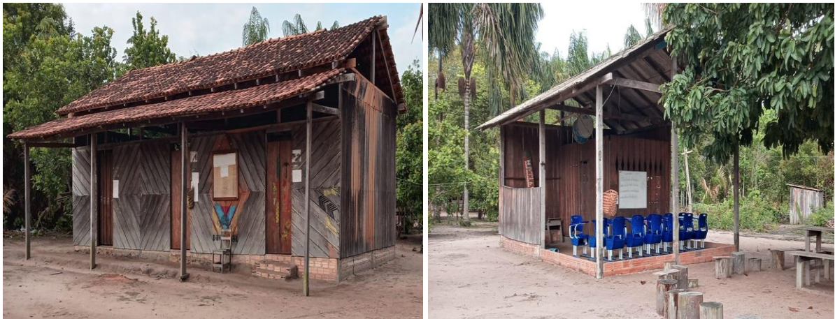
Figura 2. Foto da estrutura física da escola da Aldeia Novo Lugar (vista externa)
