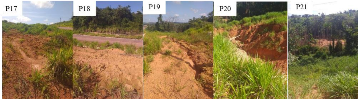
Figura 8. Registros de campo em uma área de voçoroca em Rurópolis, Pará.
