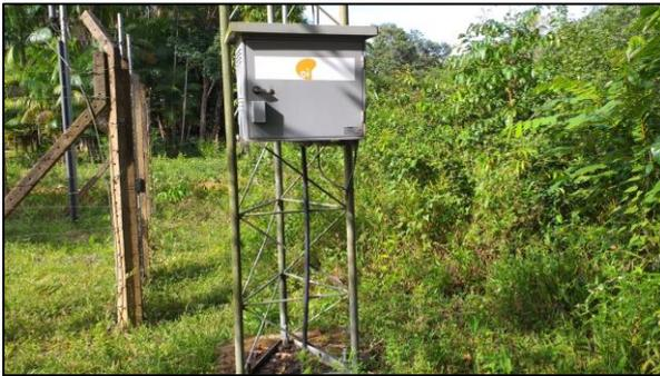
**Fotografia 156** - Sistema de comunicação abandonado e sem funcionamento em Tauari.
