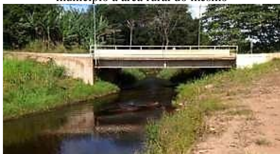
Figura 06 - Ponte que interliga o centro do município a área rural do mesmo
