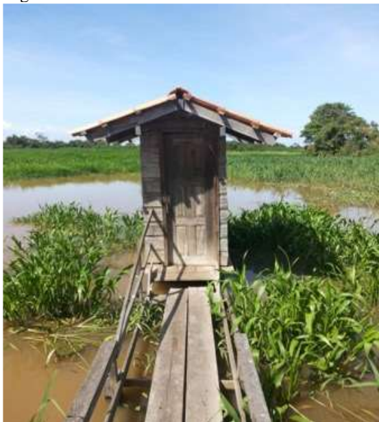
Figura 19 – Sanitários rudimentares cavados no chão
