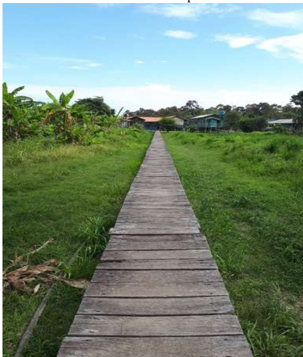
Figura 34 – Foto da passarela que liga a escola ao rio – Boca de Cima de Aritapera
