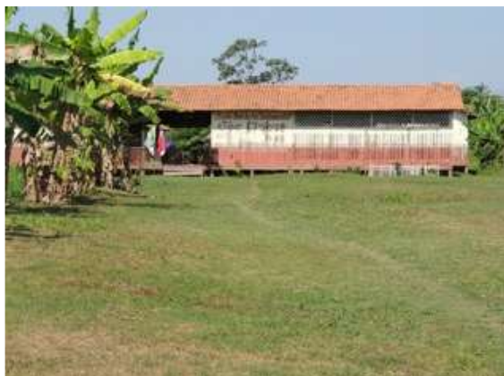
Figura 71 – Atual Escola São Ciríaco, construída em 2010
