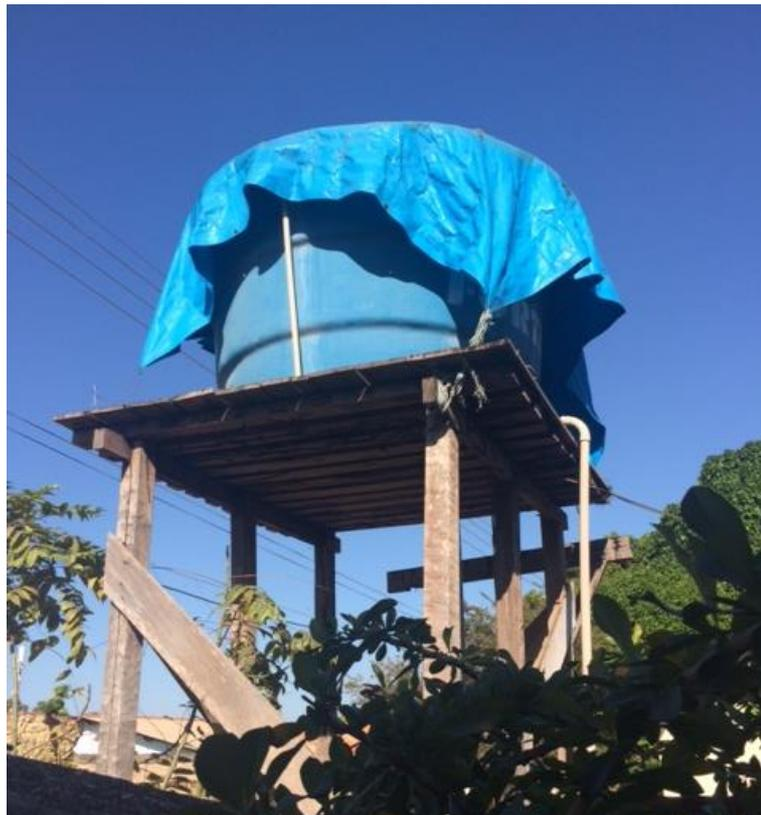
**Figura 13.** Reservatório suspenso de água (caixa d'água) na escola C de Santarém, desprovido de tampa e coberto com lona, Pará, Amazônia.
